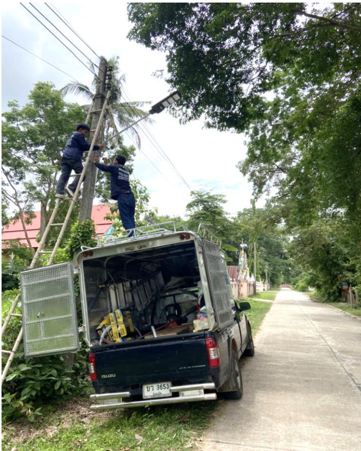
จุดที่ 3 เสาไฟฟ้าที่สวนหญ้าข้างกำแพงวัดทิศเหนือวัด
